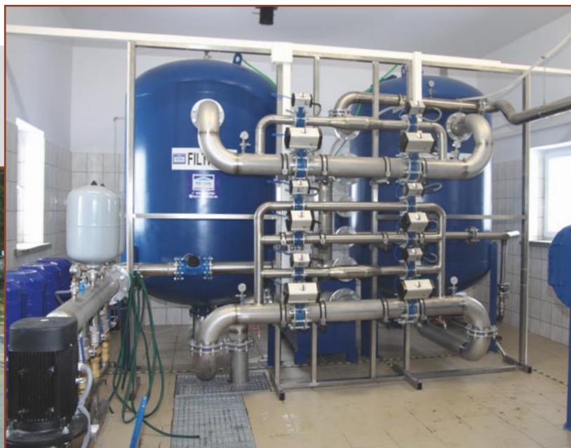
Rozbudowa stacji w Omule nastąpiła w ramach Programu Rozwoju Obszarów Wiejskich na lata 2007-2012
