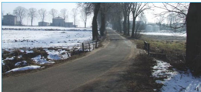
Na zdjęciu zrealizowany w ubiegłym roku pierwszy etap inwestycji
