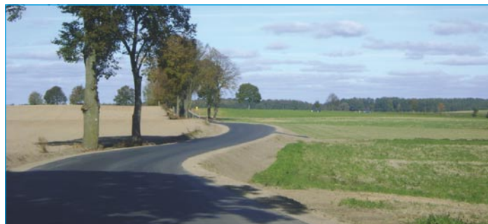
W zakres zadania wchodzi przebudowa drogi oraz mostu Gmina Lubawa. Nowa droga w Targowisku
