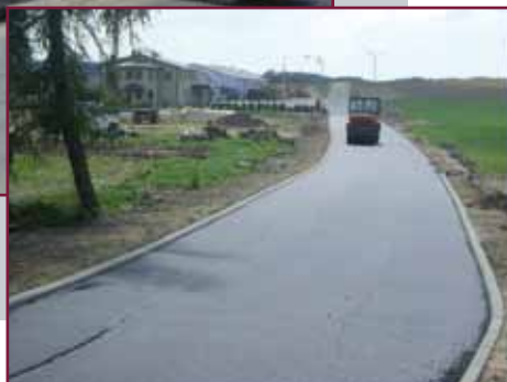
Ostatnie prace przy przebudowie drogi w Wałdykach
