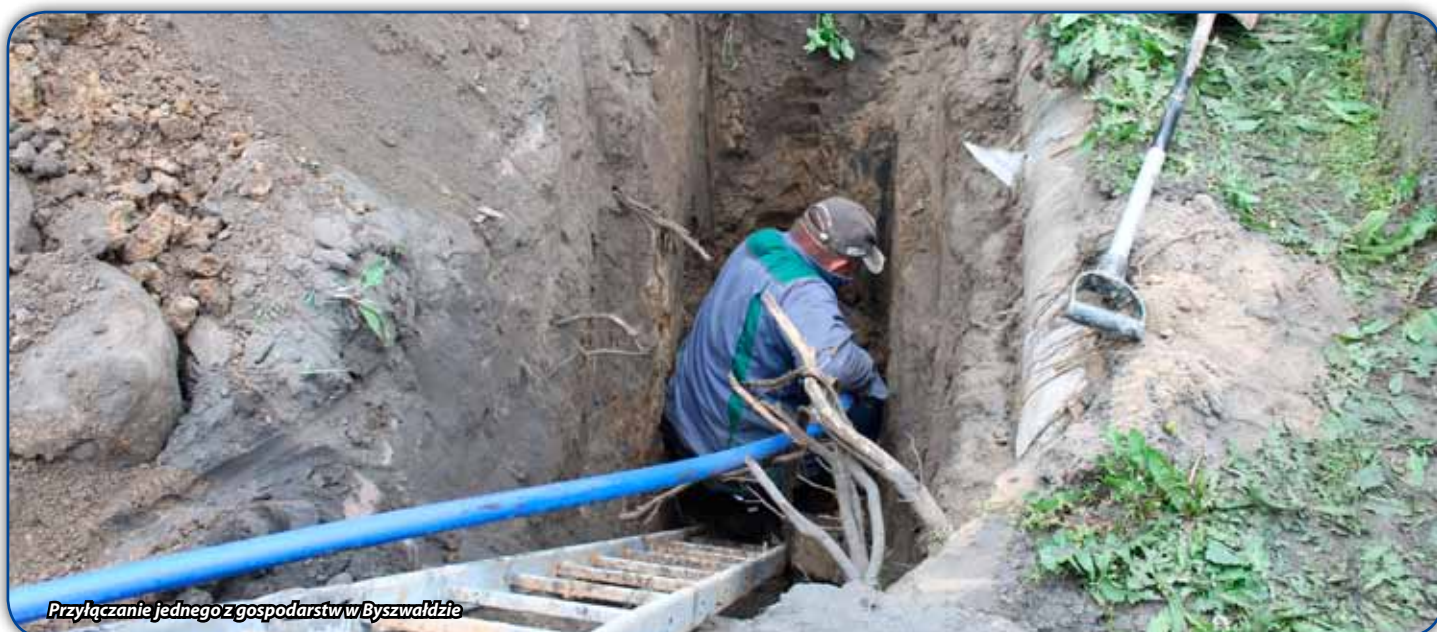
Proces przeciągania rury
