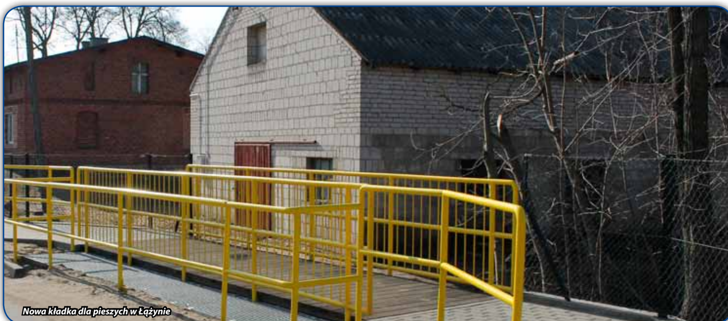
Fragment ścieżki rowerowej i zmodernizowanej drogi na odcinku z Fijewa do Tuszewa
