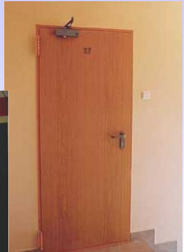
drzwi przeciwpożarowe
